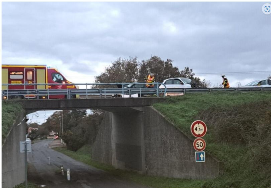
L'accident s'est produit lundi 18 novembre 2024, au niveau du pont passant au-dessus la rue de la Chaussée, à Pornic. ©Laurent RENON
